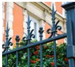
PINTURA DE GRADES
